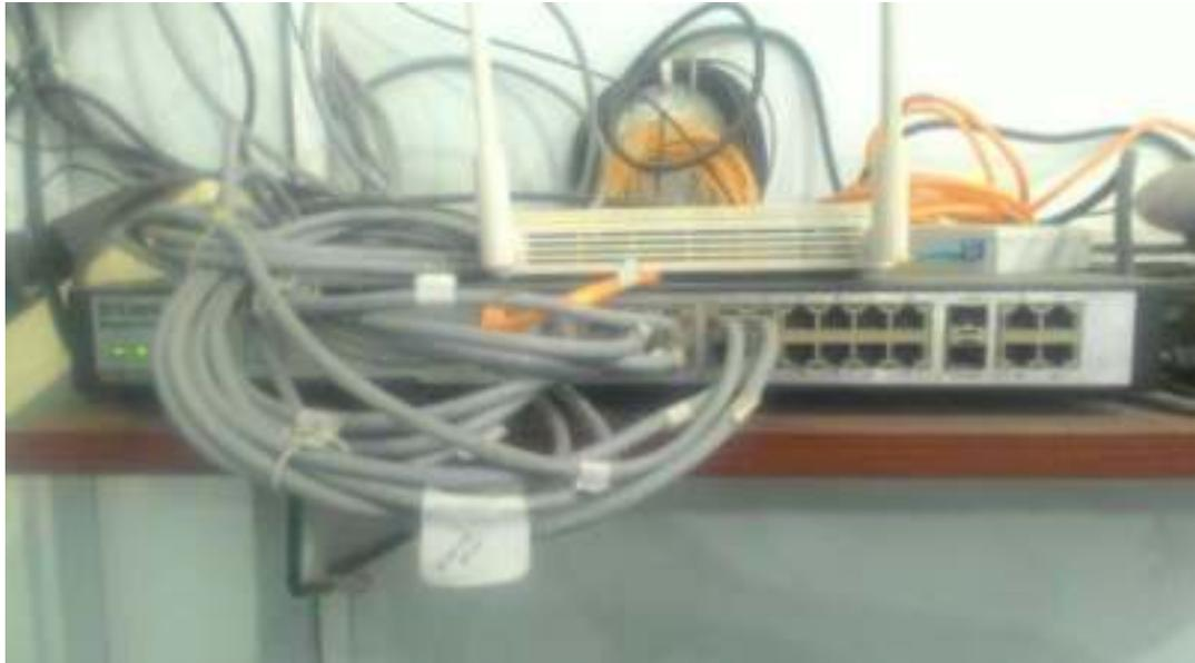
Gambar 25. Perangkat Switch D-Link 24 Port Untuk Jaringan LAN
